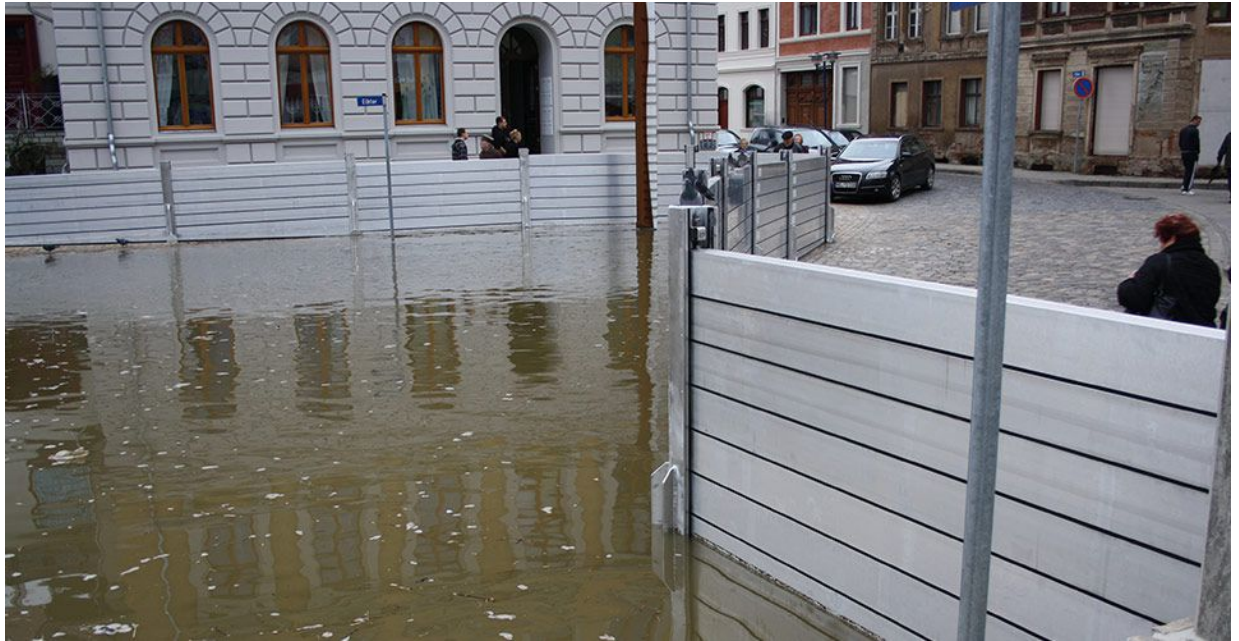
Εικόνα 1.2 Αντιπλημμυρικός τοίχος σε πόλη της Γερμανίας
